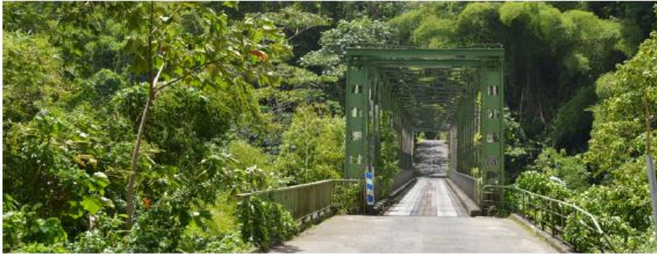
Arrivée sur le territoire de Grand'Rivière après avoir franchi les deux ponts métalliques.
