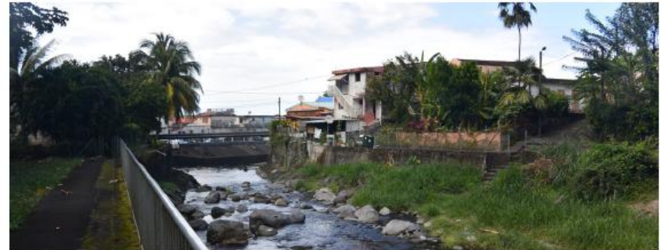
Unique passerelle piétonne connectant Vieux Bourg au Bourg.
