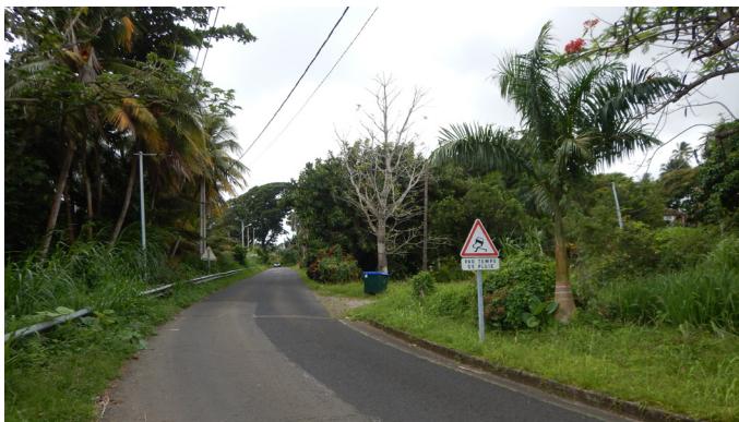
La RD10 n'est pas sécurisée pour les piétons.
