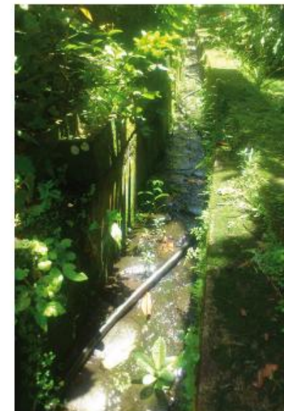
Réseau de canalisation naturel au sein du domaine
