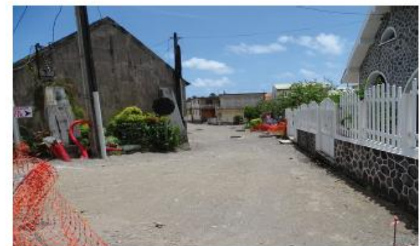
Travaux de réfection des réseaux d'assainissement.
