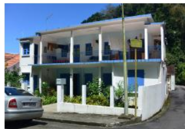
Maison date de la 2ème moitié du 20e siècle en béton avec toit-terrasse
